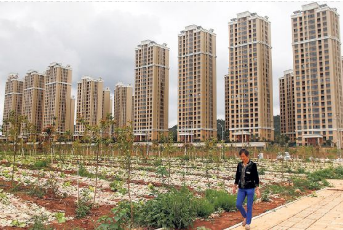
Edificios residenciales en la ciudad de Chenggong, en China. / PAULO FRIDMAN
